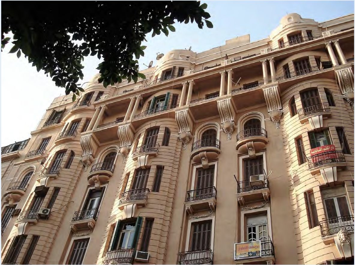
Φρεσκοβαμένη πολυκατοικία της οδού Abdel Khalek Sarwat
